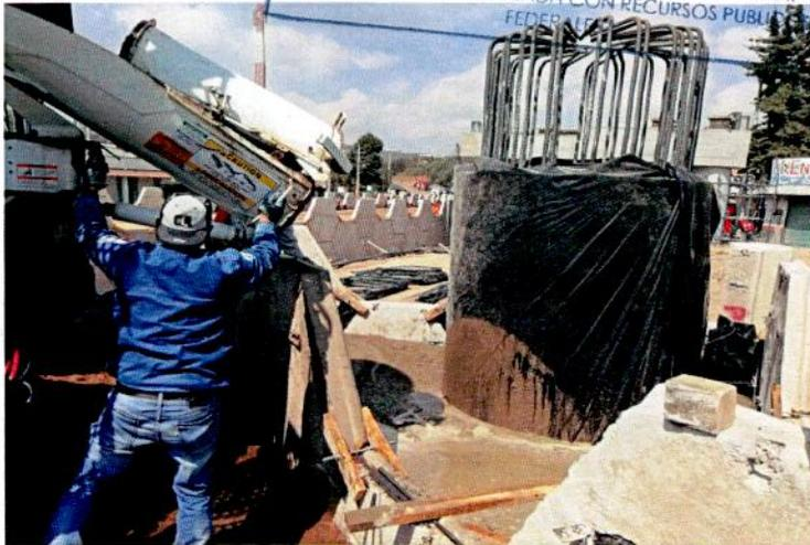
Suministro y colocación de Relleno Fluido de F'c=45kg/cm2 en muros
