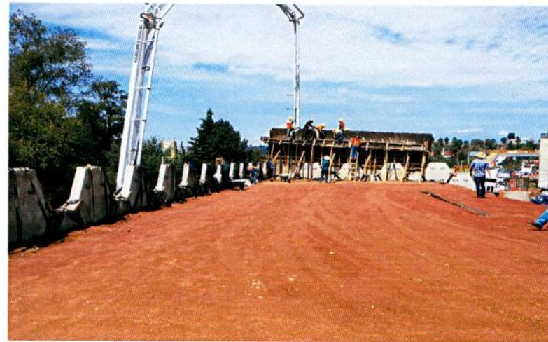
Rellenos compactados por capas al noventa y cinco por ciento (95%) para formar la estructura de Tierra Armada.
