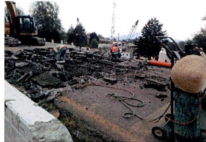
DEMOLICION DE CARPETA ASFALTICA.
