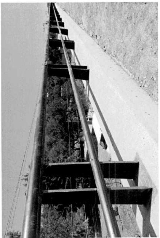
Parapetos de acero, tubo de acero galvanizado
