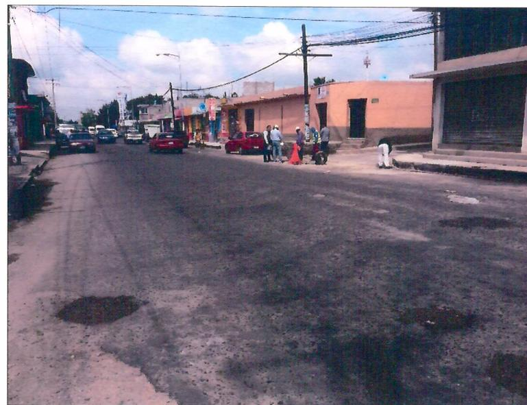
EN LA CARPETA ASFÁLTICA ENTRE LOS CADENAMIENTOS DEL KILÓMETRO 2+120 AL 2+580, SE DETECTARON BURBUJAS Y FUGAS DE AGUA QUE ESTÁN OCASIONANDO BACHES.
