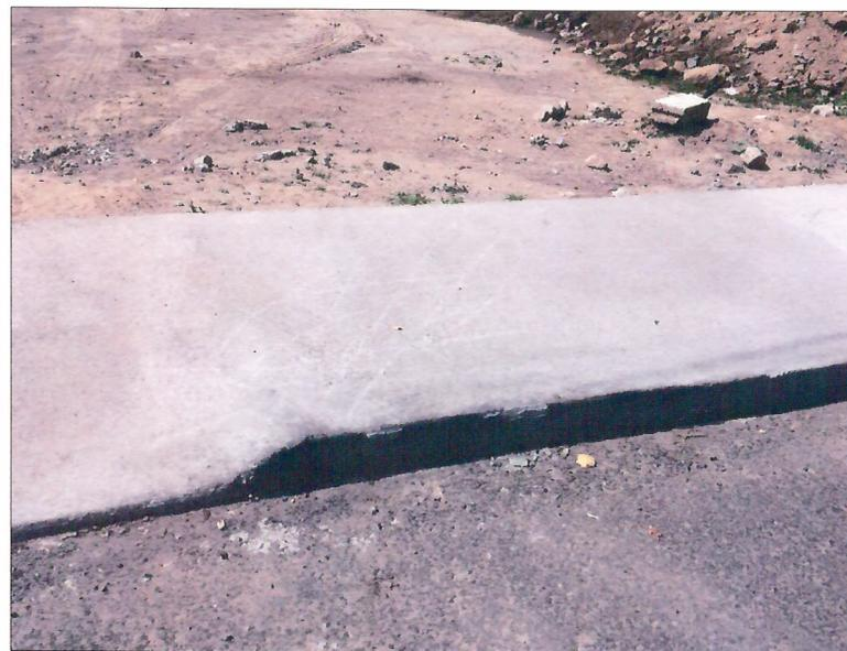
SE CONSTATÓ QUE EL COLADO DE LA GUARNICIÓN Y DE LA BANQUETA EN VARIOS TRAMOS DEL CADENAMIENTO COMPRENDIDO ENTRE LOS KILÓMETROS 0+000 AL 1+580, SE REALIZARON MONOLÍTICAMENTE Y POSTERIORMENTE SE RAYO LA FORMA DE BANQUETA Y GUARNICIÓN.
